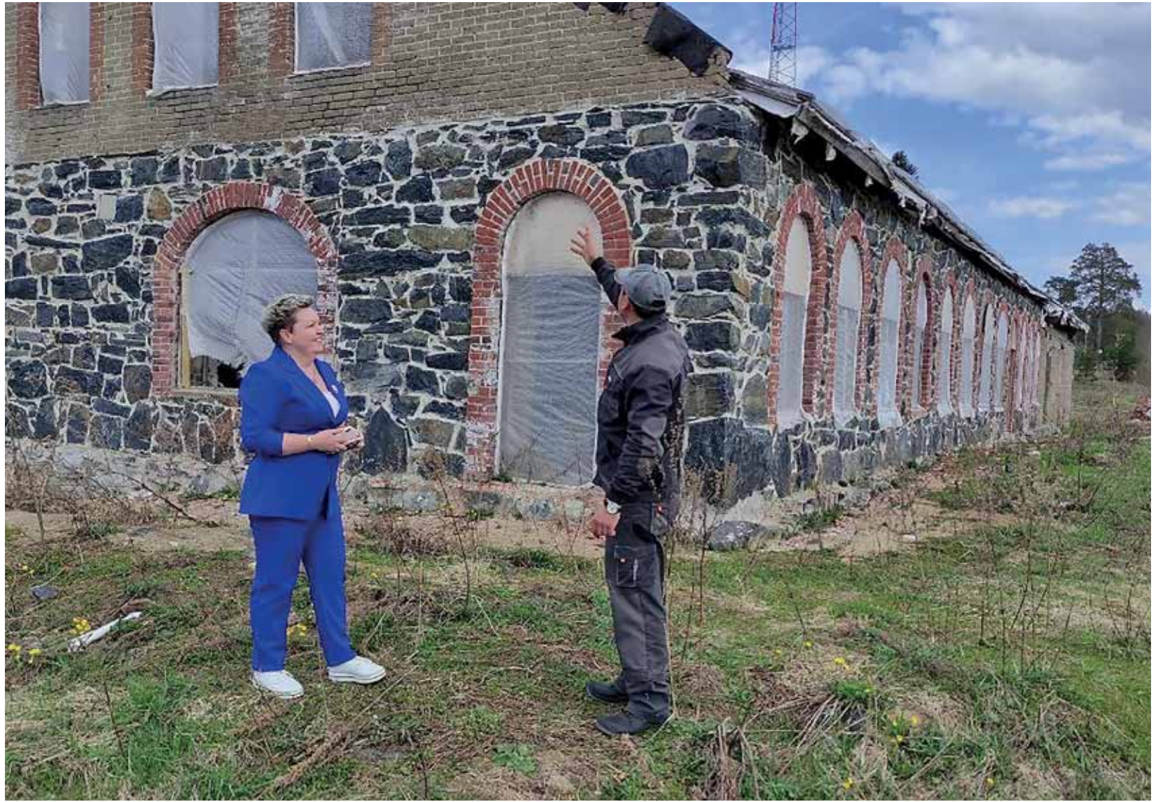
Karjalan kehityskorporaation johtaja Jelena Klimtšuk (vas.) ja urakoitsija seisovat entisen tallin lähellä. Kunnostustöiden jälkeen rakennuksessa on kokoussali. KUVA: KARJALAN KEHITYSKORPORAATIO
